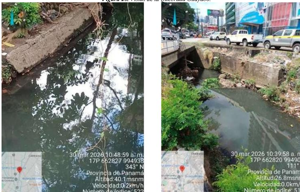
Figura 20. Vistas de la Quebrada Guayabo.
