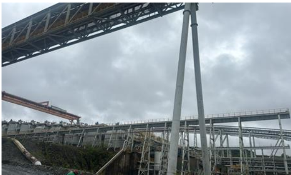
Fotografía 7-26 Vista exterior área de flotación
