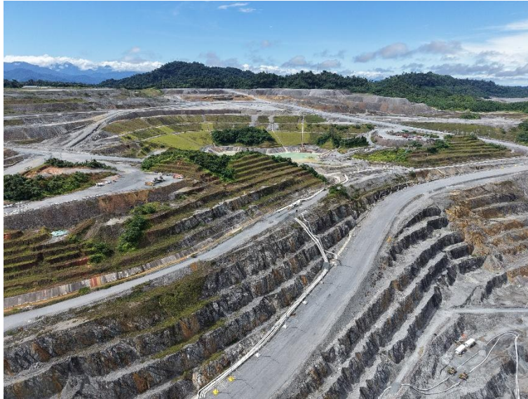
Fotografía 7-73 Monitoreo estabilidad de taludes Tajo Botija
