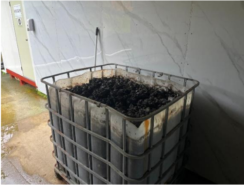
Fotografía 7-90 Manejo de lodos generados en la PTAR
