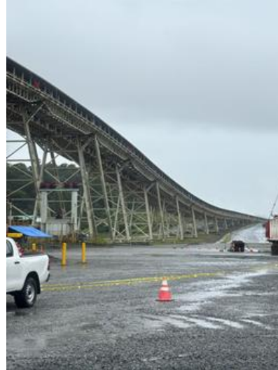
Fotografía 7-16 Sistema overland de bandas transportadoras
