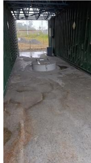
Fotografía 7-67 Almacenamiento de Iridio 192
