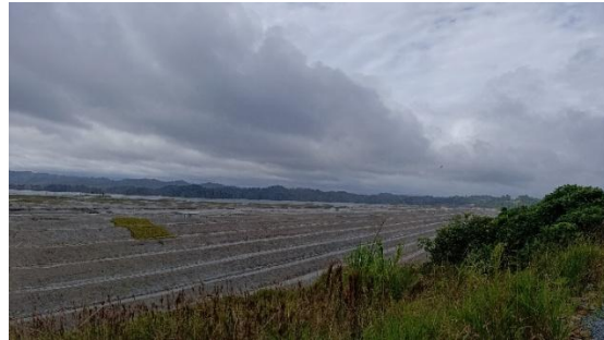
Vista general del dique norte de la presa de relaves
