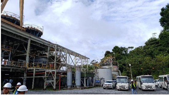
Recorrido en la planta de clasificación de arenas para la construcción del dique de la IMR
