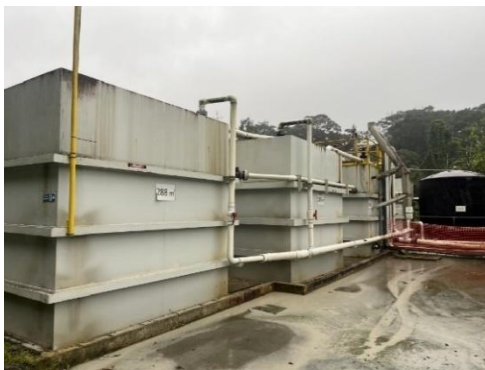
Fotografía 7-82 Planta de agua residual domestica campamento Cobre
