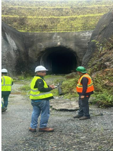
Fotografía 7-148 Portal del túnel de descarga
