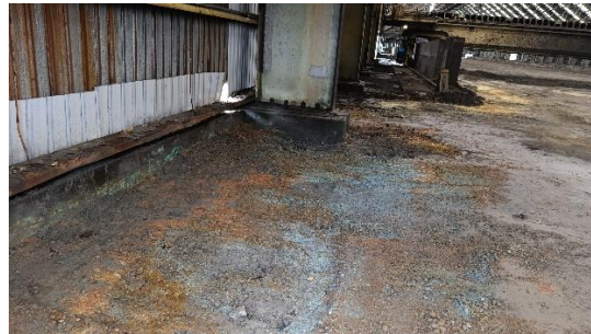
Se observa el estado actual de la bodega de concentrado de cobre.
