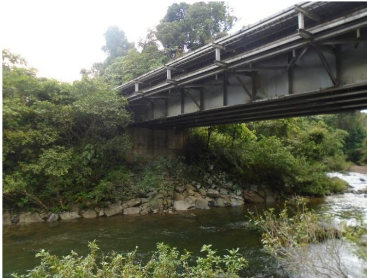
Fotografía 7-144 Inspección estructura de puente sobre río Uvero, en camino a la costa
