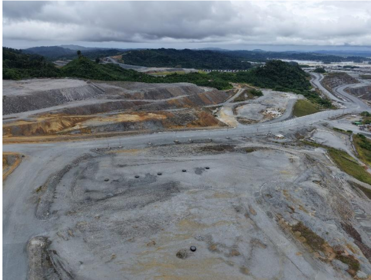
Fotografía 7-6 Talud oeste con sistema trolley eléctrico
