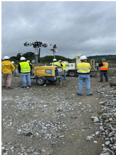
Fotografía 7-61 Estación de monitoreo geotécnico
