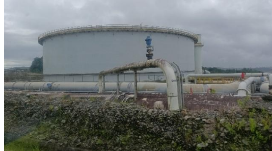
Tanque principal de agua industrial, en la actualidad en mantenimiento.
