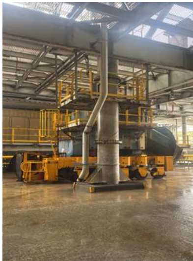
Fotografía 7-24 Estación de densímetro nuclear en molienda
