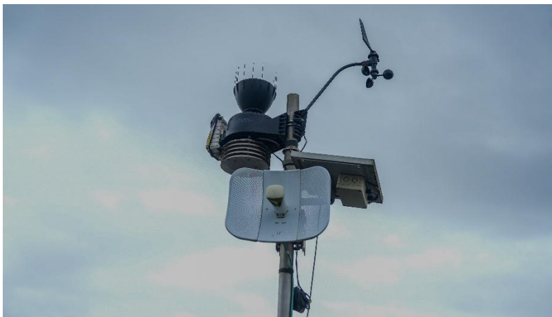
Fotografía 7-64 Sistema de Monitoreo de taludes en tajo Botija, mediante Georradar y monitoreo topográfico
