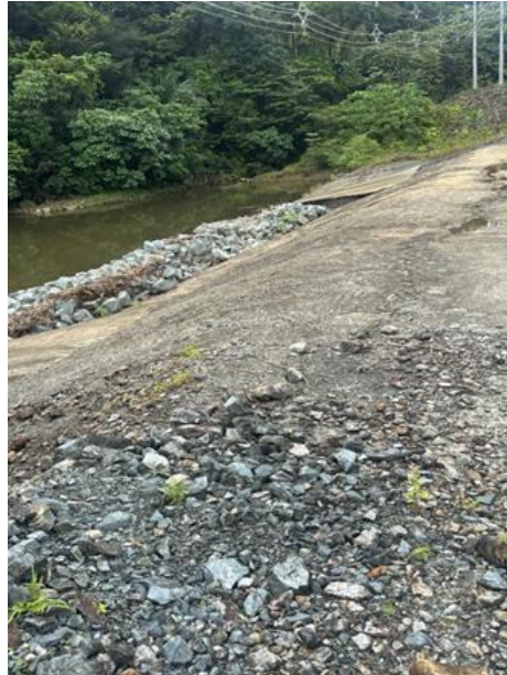
Fotografía 7-50 Dique de la poza 12
