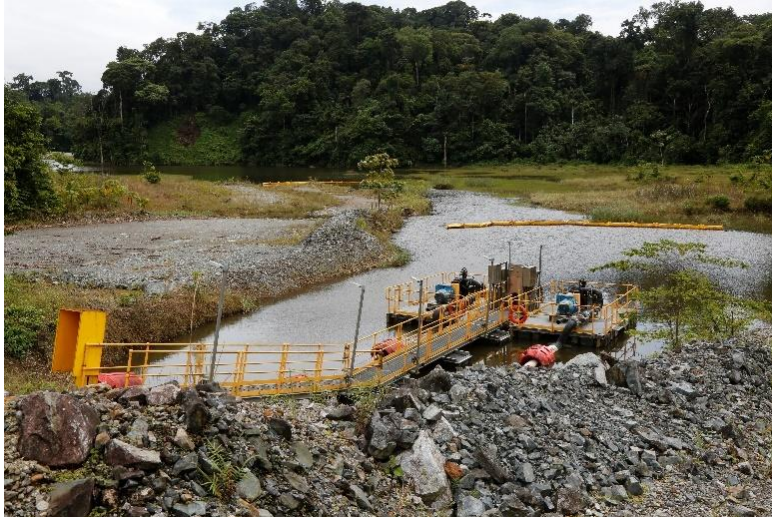
Fotografía 7-49 Estación de bombeo vista desde el acceso principal
