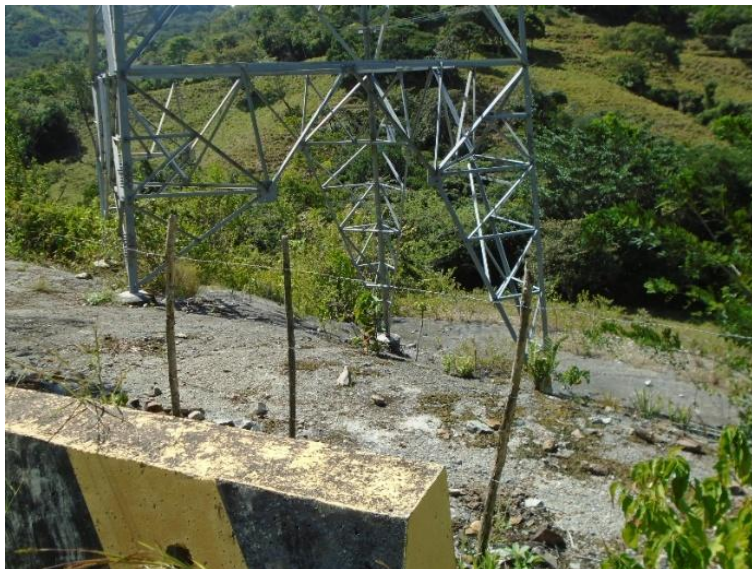
Fotografía 7-146 Inspección cimentación de estructura T-194 de tramo 2 línea eléctrica
