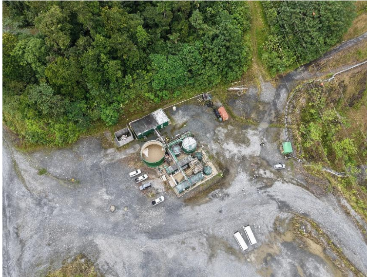
Fotografía 7-126 Deposito de cenizas y PTAR de aguas industriales
