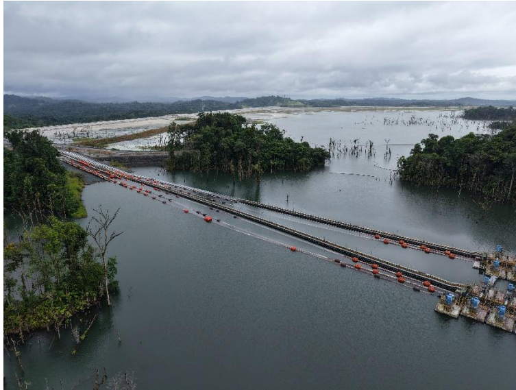
Fotografía 7-46 Recirculación de agua a proceso productivo
