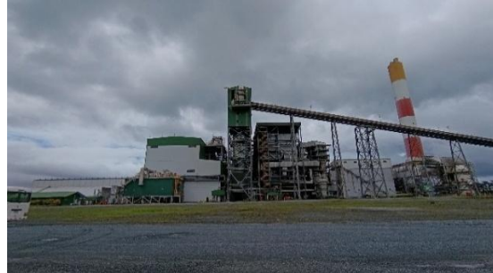
Vista general de la planta de generación de energía
