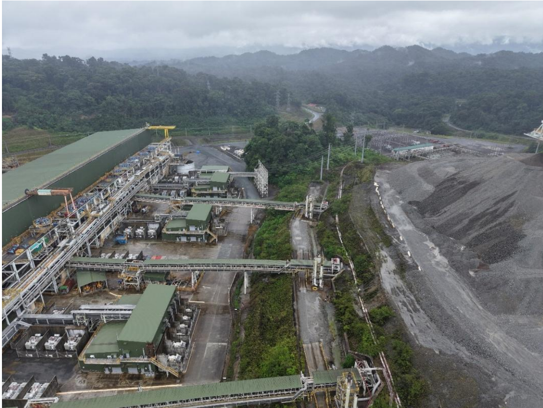
Fotografía 7-21 Vista general edificio de molienda
