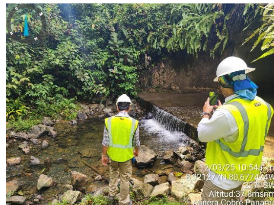
Fotografía 7-110 Continuidad de fuentes hídricas
