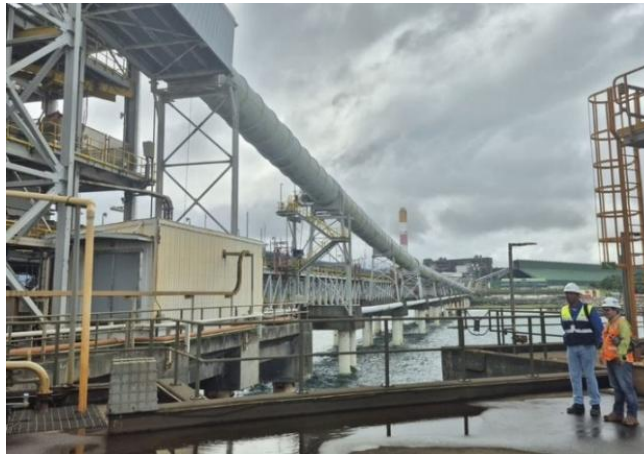
Fotografía 7-131 Revisión visual de localización y estado de sistemas de distribución dentro de terminal 2
