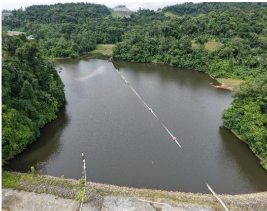
Fotografía 7-47 Vista general Poza 12
