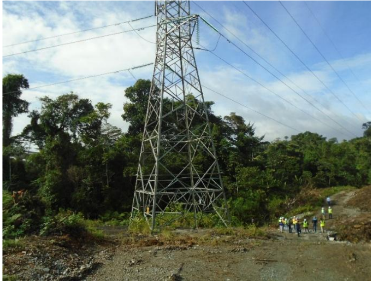
Fotografía 7-147 Inspección inicio de Tramo 3, cimentación de estructuras de línea eléctrica y estado de la servidumbre
