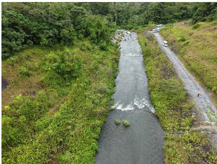
Fotografía 7-150 Túnel de descarga Minera Panamá (Cobre Panamá)
