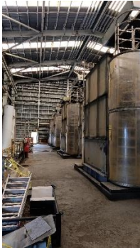
Recorrido en el área de filtros, zona de puerto
