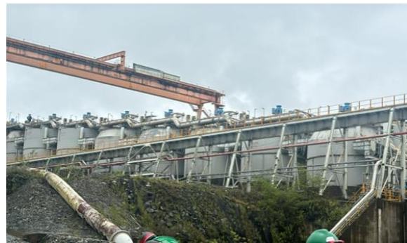
Fotografía 7-27 Celdas de flotación Rougher
