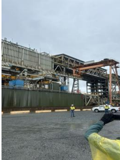
Fotografía 7-15 Edificio de trituración secundario
