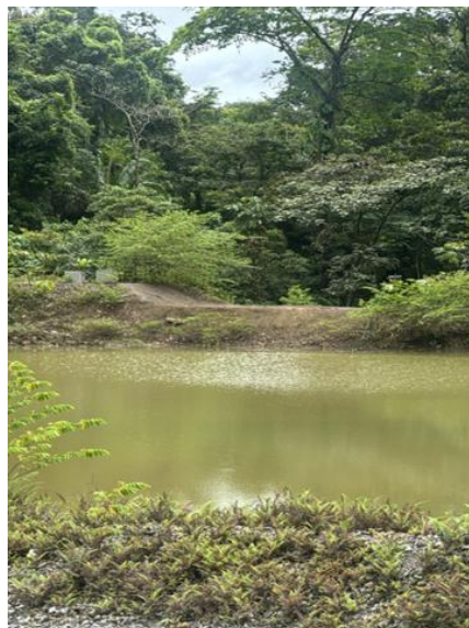
Fotografía 7-56 Vista del dique de contención de Poza 14
