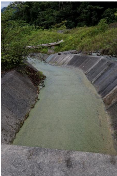
Fotografía 7-72 Canal escorrentía, manejo aguas lluvias
