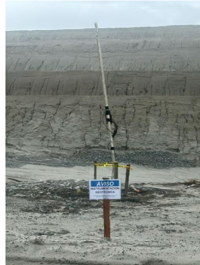
Fotografía 7-44 Señalización de instrumentación geotécnica
