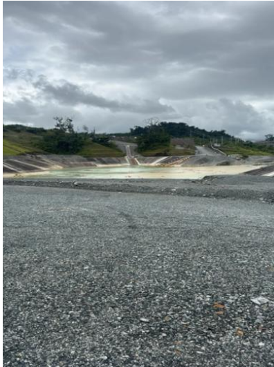
Fotografía 7-58 Vista general Poza 2
