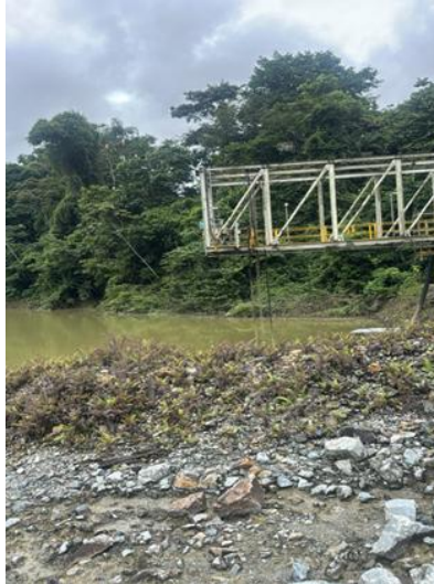
Fotografía 7-55 Estructura metálica de acceso y bombeo sobre Poza 14
