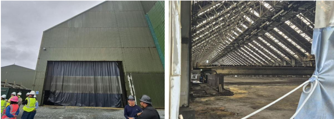
Fotografía 7-29 Revisión visual de localización y estado de sistemas de almacenamiento de concentrado de cobre
