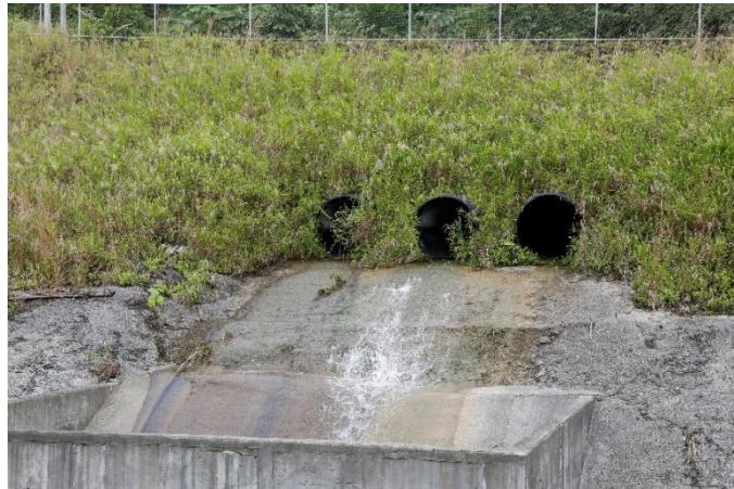
Fotografía 7-72 Canal escorrentía, manejo aguas lluvias
