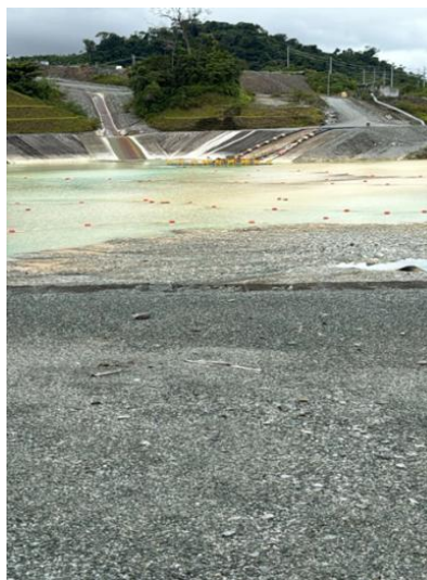
Fotografía 5-59 Poza 2 - Sistema de bombeo y canales revestidos
