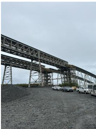
Fotografía 5-17 Cruce de bandas transportadoras
