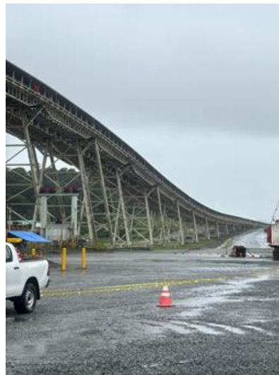
Fotografía 5-16 Sistema overland de bandas transportadoras
