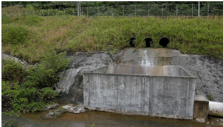
Fotografía 5-57 Estructura de descarga de aguas de no contacto
