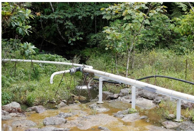
Fotografía 5-51 Zona de surgencia en el pie del Talud Poza 12
