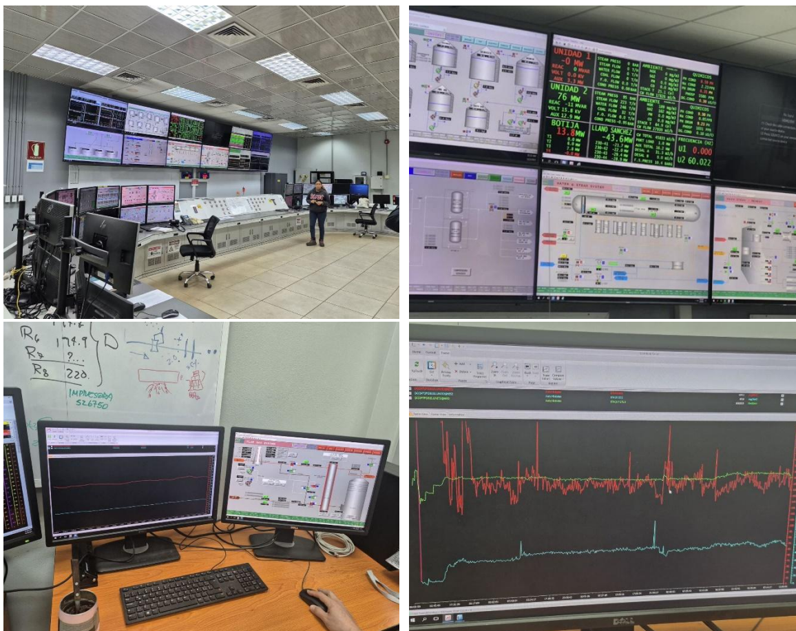
Fotografía 5-123 Revisión visual de operación en sistema CEMS Unidad 1 Planta Térmica
