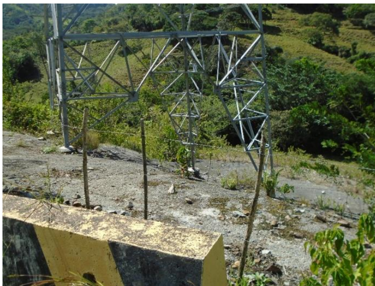
Fotografía 5-146 Inspección cimentación de estructura T-194 de tramo 2 línea eléctrica
