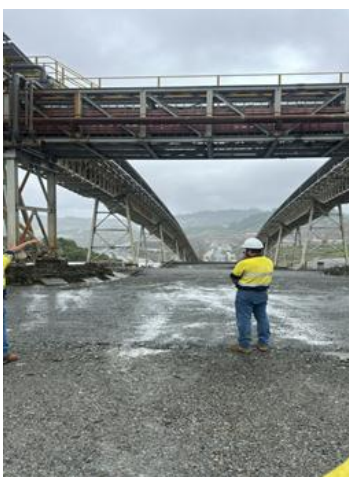
Fotografía 5-14 Sistema de bandas transportadoras - Trituración
