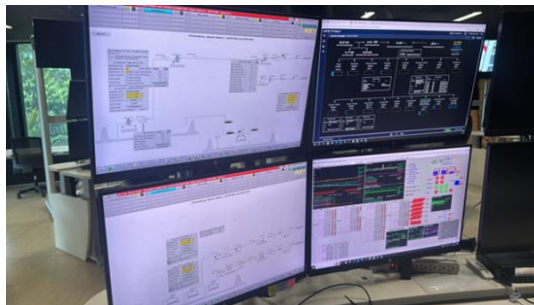
Fotografía 5-70 Pantallas sistema SCADA Siemens PCS7 y AVEVA PI Visión
