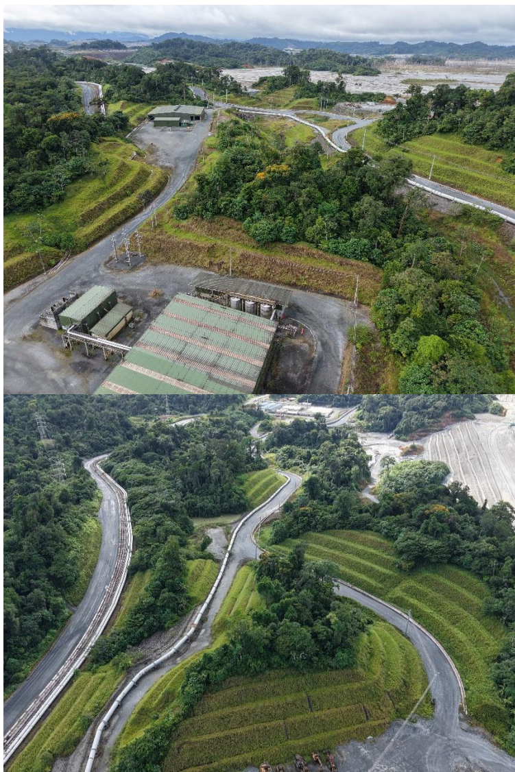
Fotografía 5-143 Conformación de taludes
